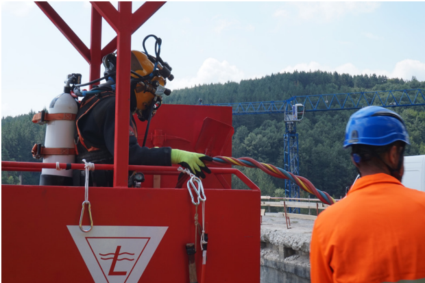
Строителните дейности по рехабилитация на стената на язовир „Студена“ започнаха и се изпълняват от водолази.
